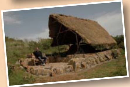
Bouw overkapte kampeerplaats
